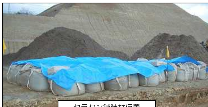
セラタン舗装材仮置
